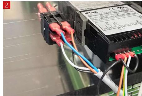
1 Öffnen Sie die Maschinenteilür und 2 ziehen die Anschlussleitungen vom Schalter ab
